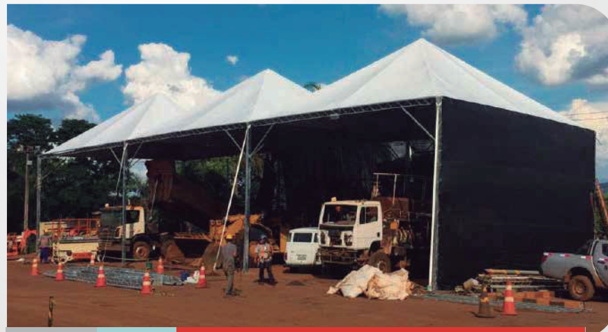
Tenda Galpão para manutenção de caminhões. Fechamento em sombrite.
