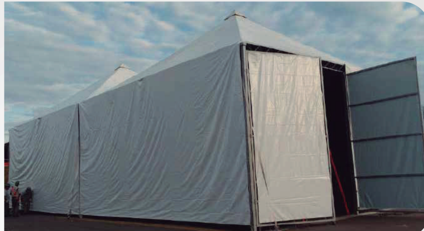
Tenda para armazenamento com portão para acesso de máquinas.
